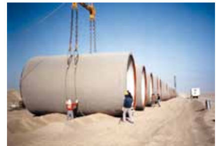
Stahlarmierung in Beton
