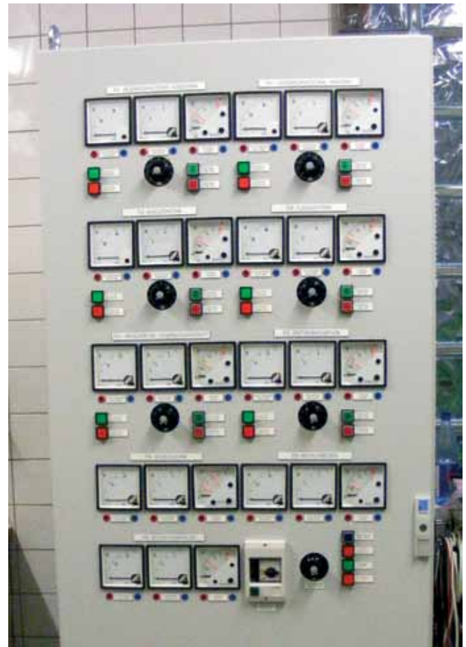
Standard Schaltschrank 2000 x 800 x 500 mm, Sockel 100 mm für DC Ausgangsleistungen bis max. 1 kW für jeden Regelkreis
