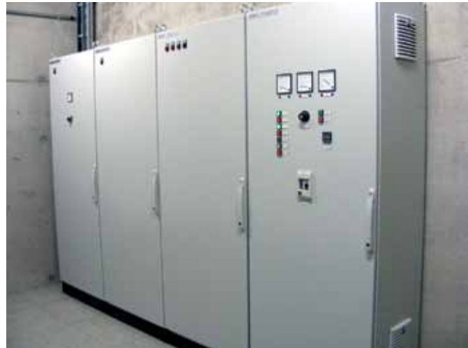
Standard Schaltschrank 1800 x 800 x 500 mm, Sockel 100 mm für DC Ausgangsleistungen bis max. 10 kW
