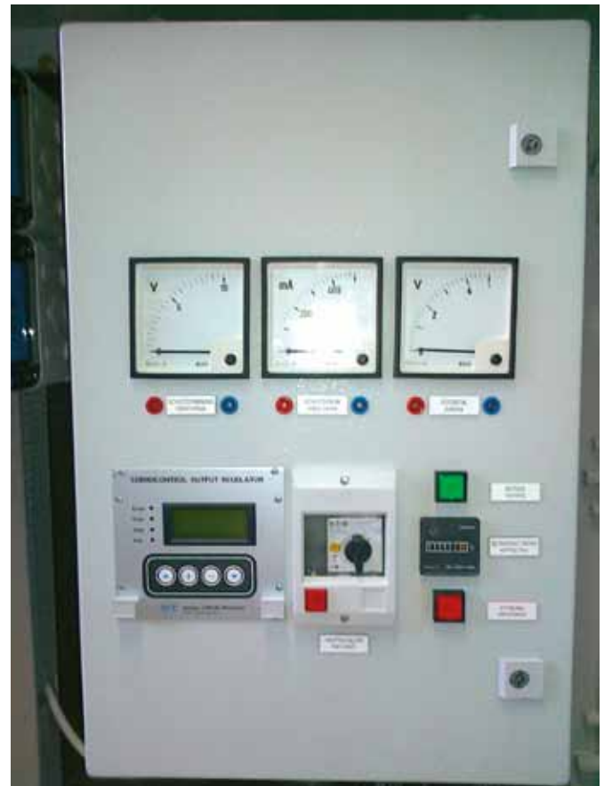
Standard Gehäuse 630 x 420 x 210 mm für DC Ausgangsleistungen bis max. 500 W
